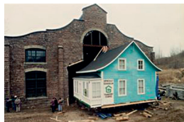
Sauvetage et intégration à la Pulperie
